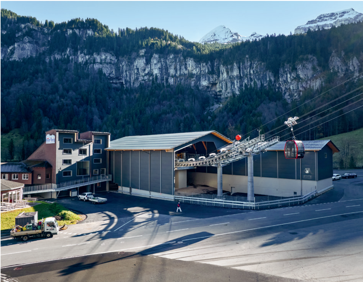
Neue Talstation Weglosen
